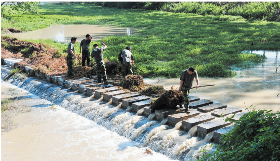
滁河干渠曾经作为董铺水库的重要水源渠道,后来由于改造转用于农田灌溉,但大面积的水草繁殖给用水带来了困难。昨日,三十岗乡民兵应急分队冒着烈日清扫滁河干渠中肆意生长的水草,以保证滁河干渠用水正常。
