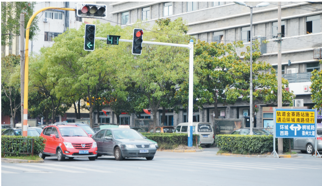
受三孝口地铁半封闭施工影响,金寨路通行压力巨大。昨日记者在金寨路与环城路交口看到,交警部门在交口设置了新的带指向的信号灯。设置了新的信号灯后,金寨路由南向北方向到环城路左转弯车辆可依据新设置的左转指示灯左转通行,路口通行效率大大提高。
