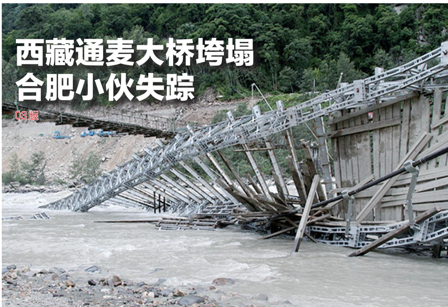
西藏林芝地区波密县通麦大桥8月2日23时左右发生垮塌。桥上一辆货车坠入河中,车上乘坐两人均已失踪。另外还有两名徒步进藏的游客失踪,其中一人为合肥人苏磊。通麦大桥是川藏公路318国道的咽喉工程,大桥设计为双塔双跨悬索桥,全长258米,主跨为210米,高31.5米。
