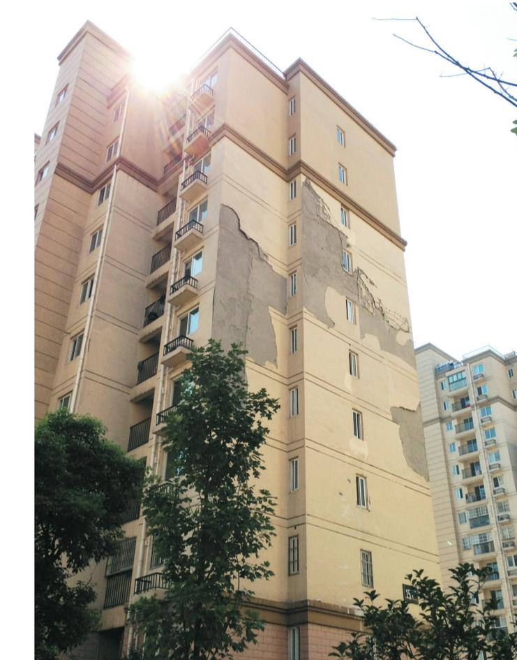
因温度低,黏性变差,才导致墙体脱落,加上之前合肥有大风天气,才会出现保温层大面积脱落。
