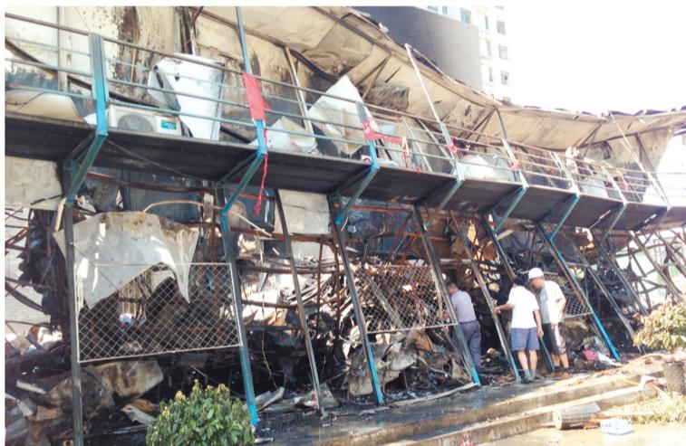
半边，现场一片狼藉，到处是被烧焦的杂物，窗户和门框也被烧得只剩残缺的空架。大火还殃及了隔壁的一栋社区服务中心，外墙面遭烟熏火燎后，塑钢窗严重变形，墙面砖脱落，连屋内也灌入大量浓烟。不过，因撤离及时，未造
