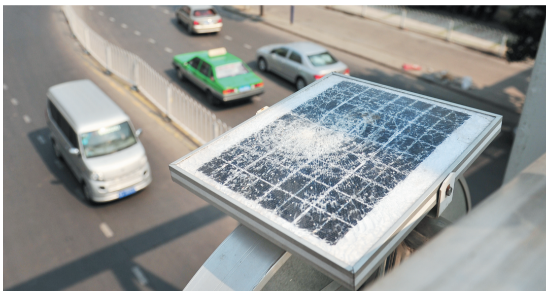
昨日,合肥市民王先生致电本报热线称,他经过合肥客运总站前的站前路天桥时,发现限高指示牌上的太阳能板出现严重损坏。随后记者将这一情况反映给12345市长热线,一位工作人员称,将反馈给相关部门及时维修。
