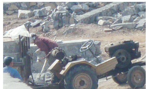
施工队在建造新的墓地
