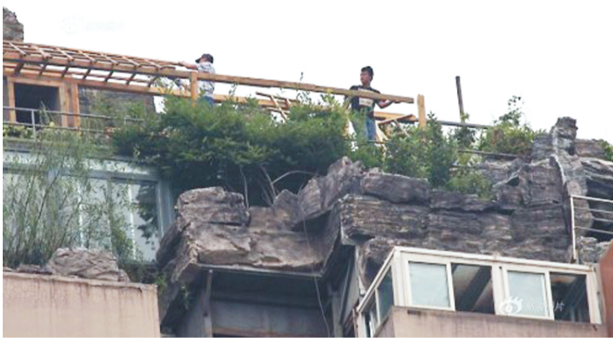
工人正在拆除葡萄架
