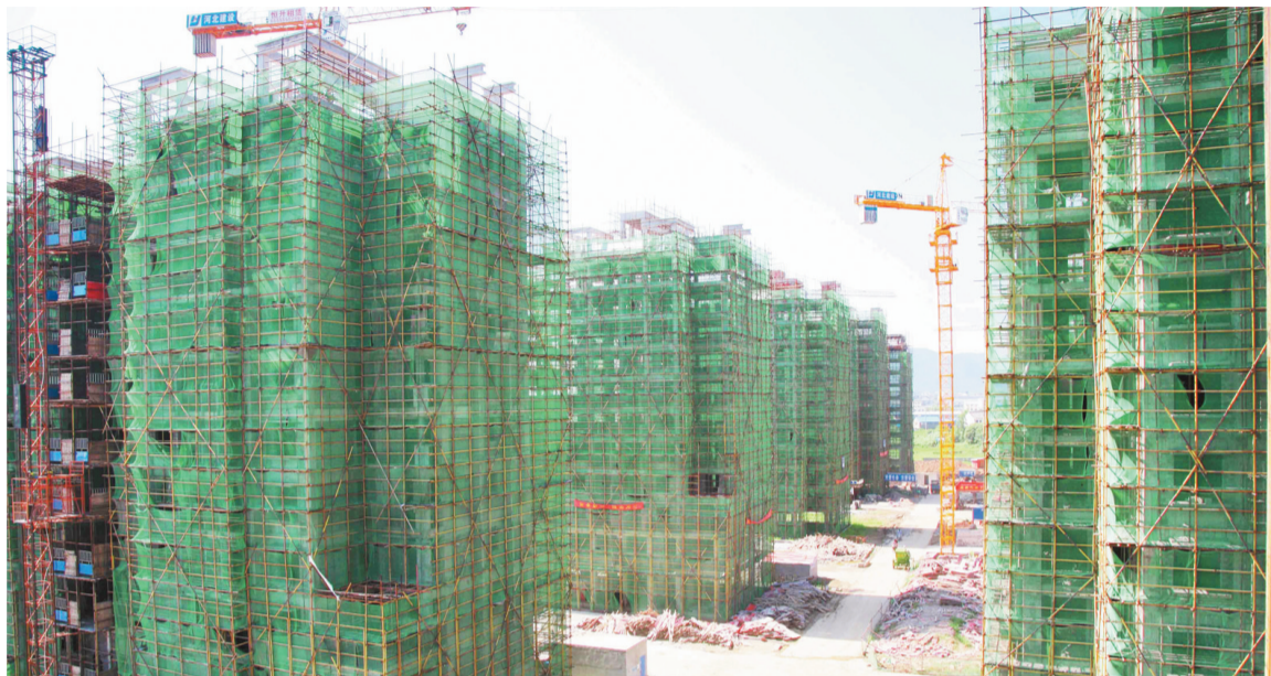
钢城安置房建设有序推进
