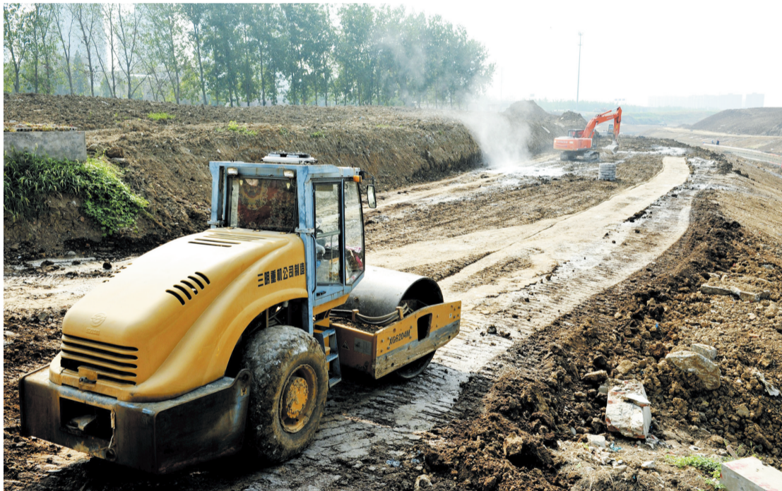
8月24日,在合肥市许小河(繁华大道至黄河路段)综合治理工程现场一片繁忙,大型机械在平整护坡,碾压路面,施工人员在打模板准备浇灌混凝土。据了解,许小河为十五里河中游的一条支流,此次综合治理主要对河道进行清淤、河堤护砌和坡岸生态绿化,防洪标准为百年一遇。 记者 倪路/图
