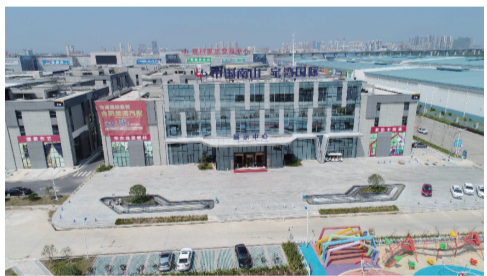
公司全景实拍
