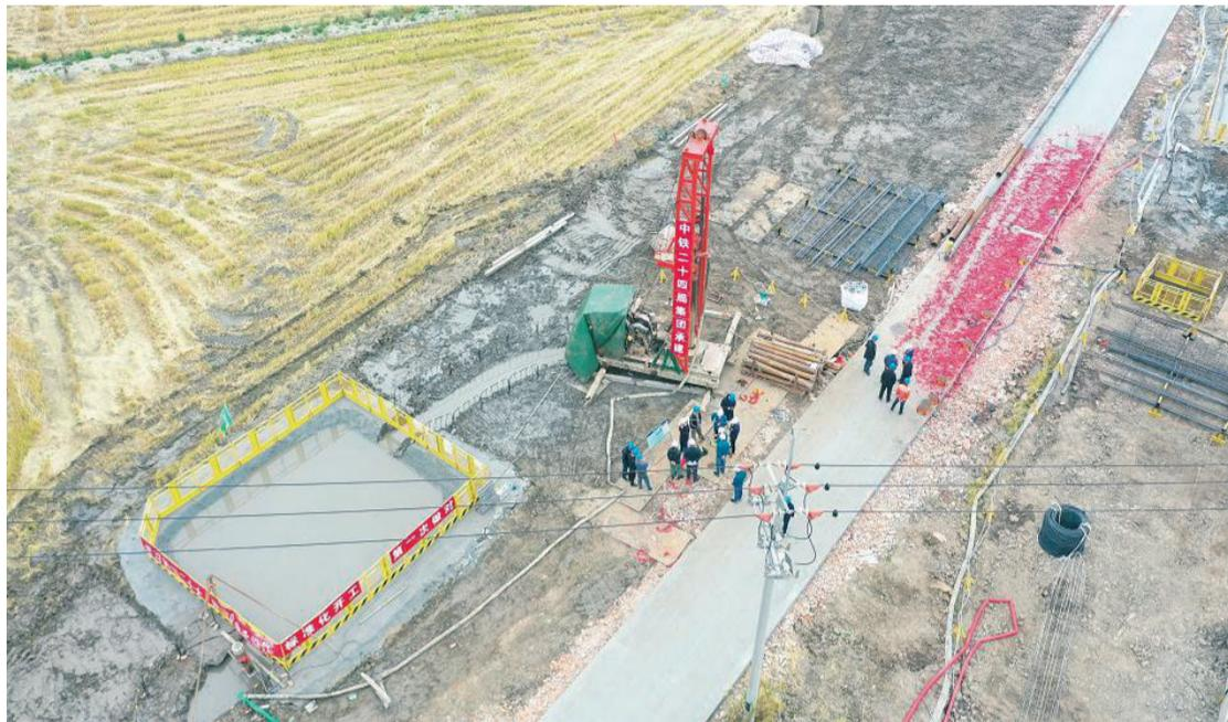
星报讯(记者 祝亮) 11月11日9时,在新建上海至南京至合肥高速铁路上海特大桥太仓市浏河镇段施工现场,随着一台旋挖钻机启动机械钻头开钻第一桩,标志着上海至南京至合肥高速铁路沪宁段进入实质性施工阶段。
