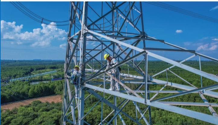
塔作业师傅穿上如棉服般厚重的全套屏蔽服。“现在气温特别高,穿短袖短裤都会觉得热,但只有这样的‘全副武装’,才能形成等电位的‘安全防护网’,确保参与不停电作业人员的安全。”贾辉说。
