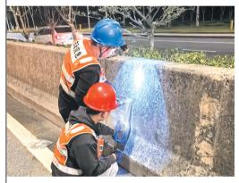
近日,合肥高新 区城管大队对方兴 大道上跨桥的挡墙路 灯检修门进行集中改 造,共更换安装约219 个新型挡墙门板,有 效解决了门板变形 锈蚀、掉落缺失等问 题,确保照明设施的 安全与高效运行。
