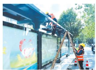
近日,合肥高新区城管大队联合公共事务管理公司集中对公交站台顶棚部分缺失、铁皮翻翘等安全隐患问题进行排查整改。目前,已完成4座公交站台顶棚的整修加固。
